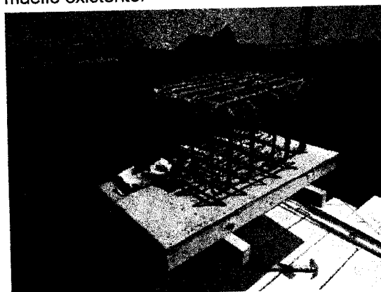
Fotografía N°12: rehabilitación de vigas de muelle existente.
