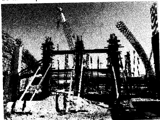
Fotografía N°09: encofrado de columnas.
