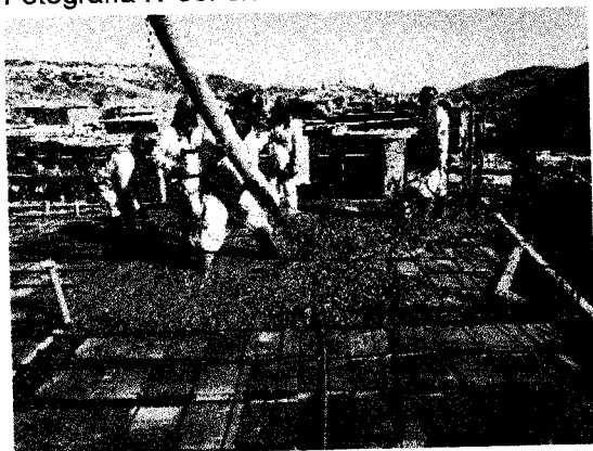
Fotografía N°11: vaciado de techo en área administrativa.
